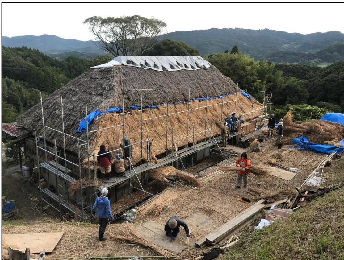
写真4 「現代の結」茅葺屋根を再生するために行われた（林良樹提供）
