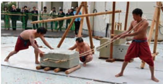
下にコロを置き石を運搬する方法の復元
