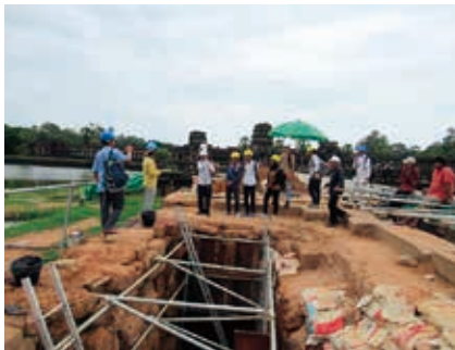
アンコール・ワット西参道修復現場見学 (8月13日)
