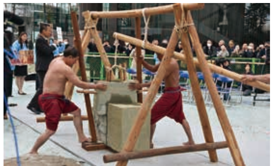
石同士を擦り合わせる作業の復元（バイヨンのレリーフにも見られる）
