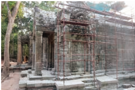
修復の進行状況
