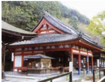
阿弥陀堂 修理前の外観
