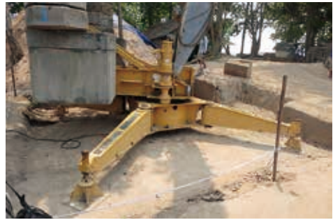
タワークレーン足元
