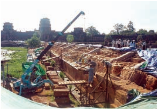
アンコール・ワット西参道第1期工事
