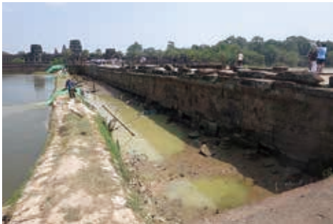
排水後（入口からテラス方向見る）
