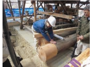
轟門 柱の根継ぎ
