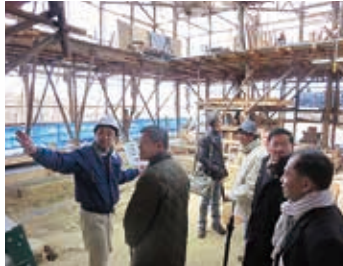
轟門 全解体修理現場
