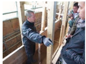
築地塀 榎谷貴史による版築説明
