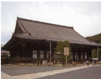
御影堂 修理前の外観
