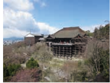
本殿左手の轟門覆い屋
