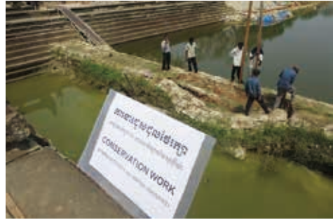
作業周知の看板設置
