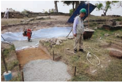
タワークレーン設置の準備
