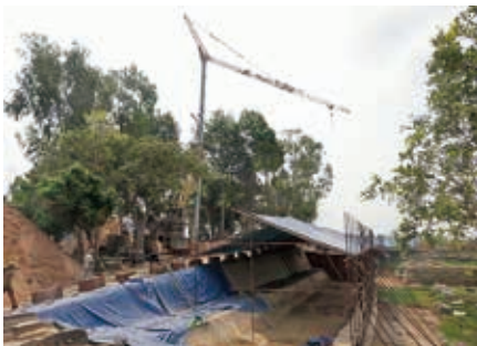
タワークレーン配置状況
