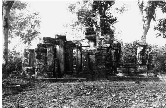
図5 D11現況写真
