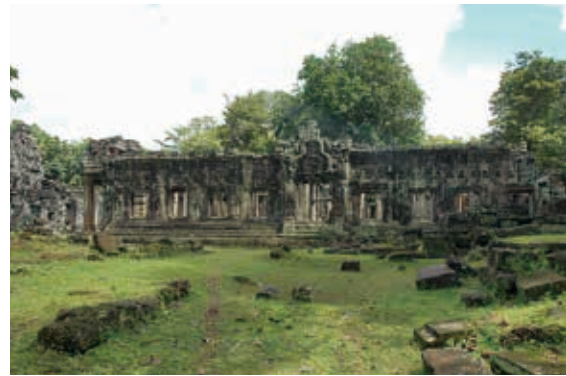
写真2 前柱殿 C09 (南から撮影)
