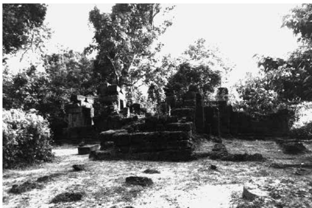
図2 D02現況写真
