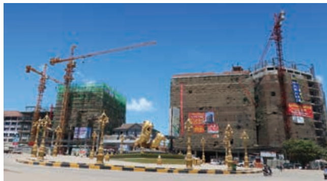
写真4 シアヌークヴィルのライオン像の背後には大型ビルが建設中（2019年3月10日）
