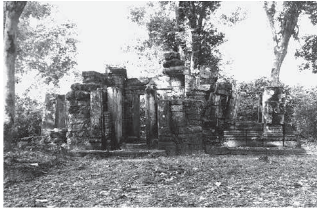
図5 D11現況写真
