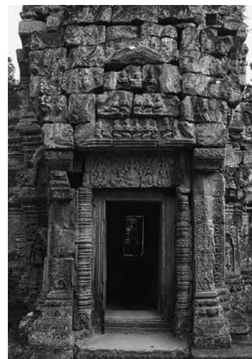
図5 出入口装飾（プレア・カン、北側副次的伽藍）
