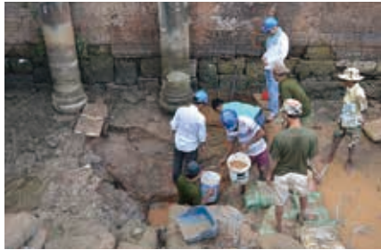
2. トレンチ内土砂除去作業の様子
