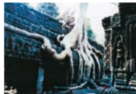
写真-2-2 樹木による建物の破壊
