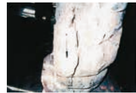
写真-2-8 石柱の亀裂とクラック
