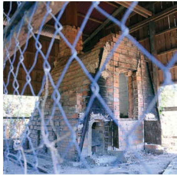
図15 耐火煉瓦積みの昇炎式構造体をもつ地上式窯
