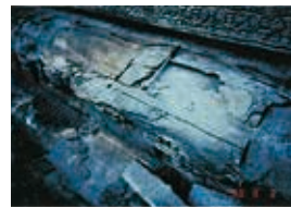
写真-2-7 砂岩の剥離
