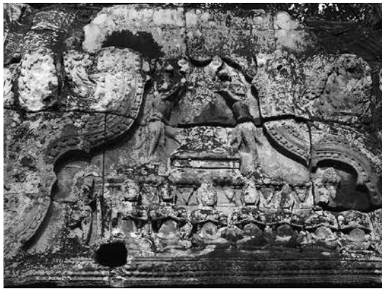
図17 ムーガパッカ・ジャータカ（第1周壁東塔門南側通路西面出入口）
