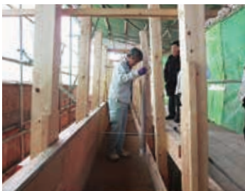
築地塀 版築作業
