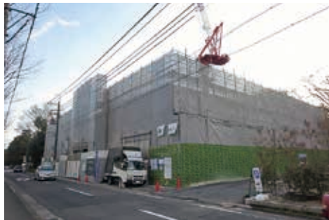
神社敷地内マンション建設工事現場
