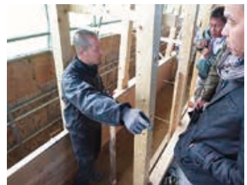
築地塀 榎谷貴史による版築説明
