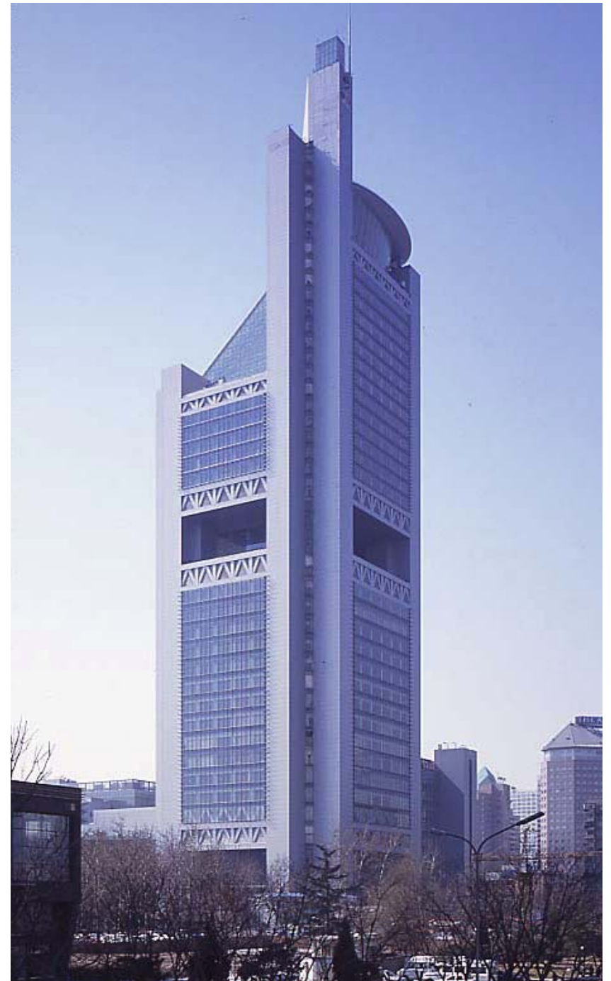
8-3: View of building from northeast. The building's steel superstructure creates a three-dimensional stacking composition. 北東側外観。鉄骨のスーパーストラクチャーによって立体的に積層させた構成としている。 074 | 075
